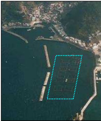
消波堤により造成された養殖場(破線内)
