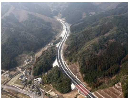
【供用開始した本耶馬溪耶馬溪道路】
