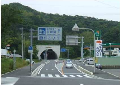
【国道197号 古宮小志生木バイパス(大分市)】
