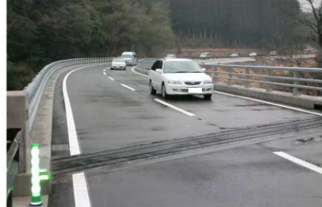
【(主)三重野津原線 矢田工区(豊後大野市)】
