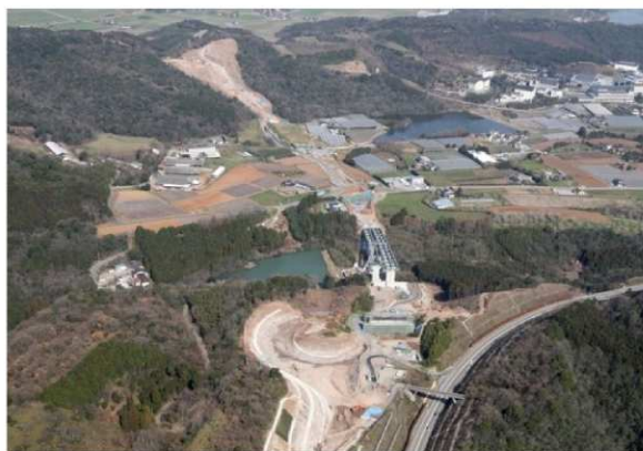
【東九州自動車道宇佐IC付近の整備中の状況】
