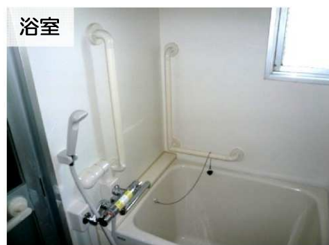
手すり、給湯器、シャワーを設置しました。
