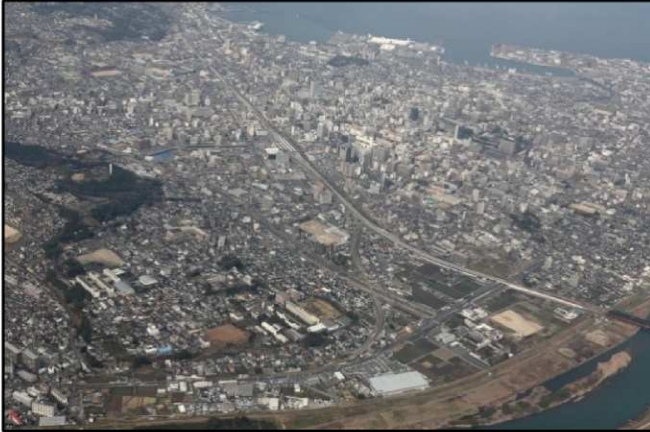
【工事が進む大分駅周辺総合整備事業】H24.3
